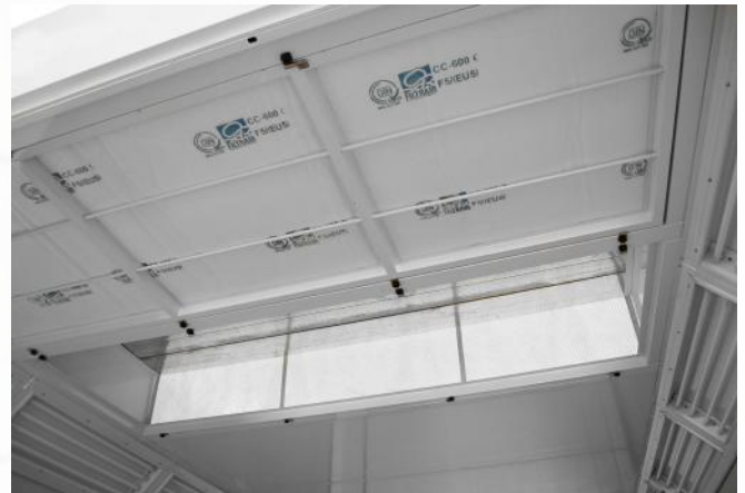
Paneles filtrantes del techo
